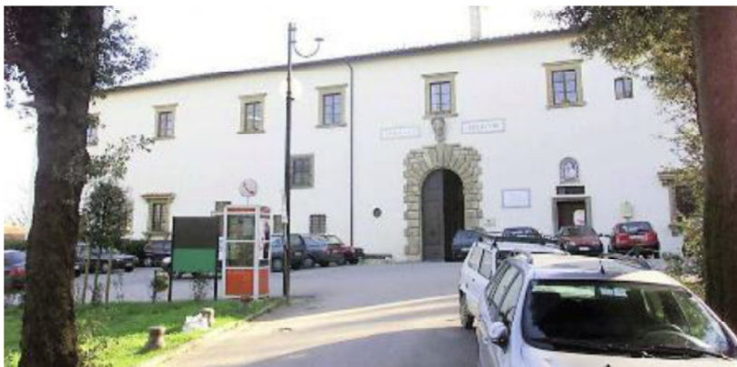
L'ospedale 'Serristori' a Figline, da anni al centro di un progetto di ridimensionamento e ristrutturazione
